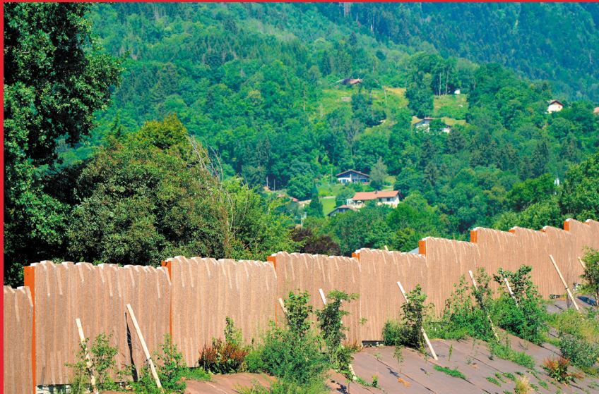
Panneaux Capremib en béton de bois, installés en 2022 le long de la RD6, au niveau du contournement de Marignier, en Haute-Savoie. Architecte : Strates OA © Lycom
